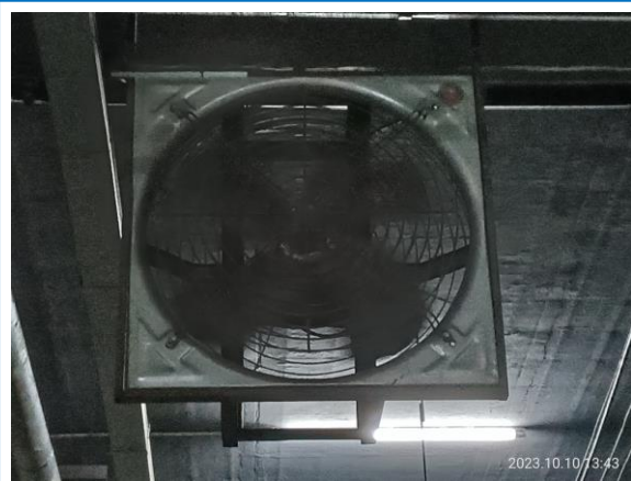
รูปที่ 3-10 เครื่องระบายอากาศในพื้นที่จอดรถ
