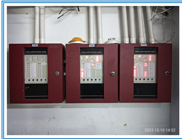
รูปที่ 3-39 อุปกรณ์แจ้งเหตุเตือนภัยและระบบควบคุมการแจ้งเหตุเตือนภัย
